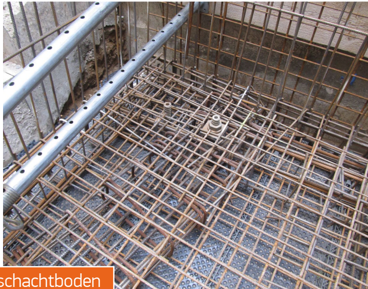
Aufzugsschacht im Bauzustand
